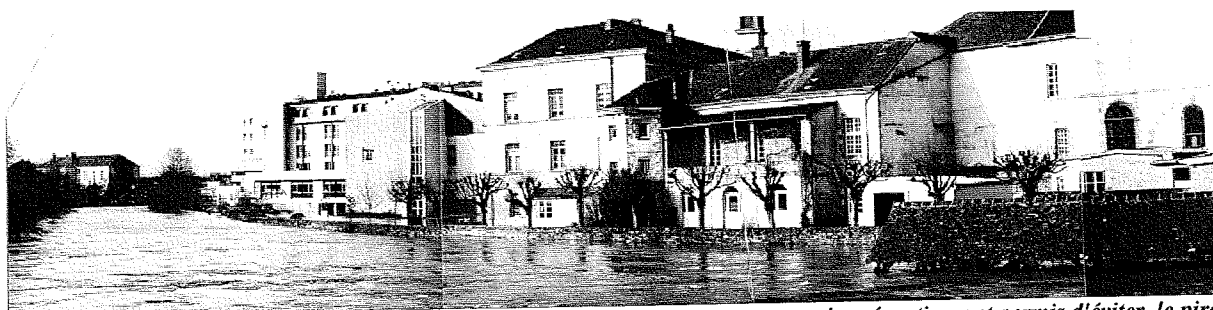
Janvier 1995, hôpital d'Alençon : des travaux d'amélioration et des mesures de prévention ont permis d'éviter le pire
