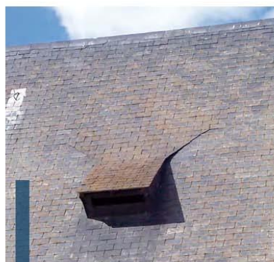
Chiroptière sur le toit d'une église
