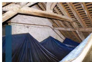
Bâches de protection dans un comble
