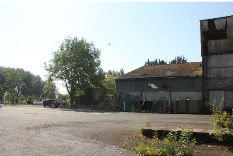
Vue sur l'arrière du site et la station d'épuration
